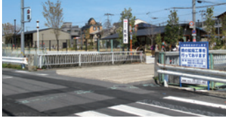
道路拡幅工事を予定している北条12号線(大正橋)
