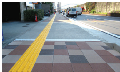
バリアフリー化の整備が進み、フラットな路面になった歩道(住道2丁目)
