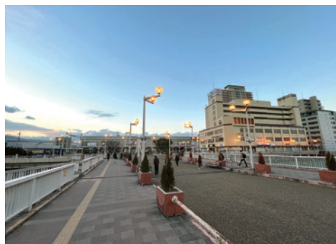
利用しやすい環境整備を行うため、整備方針が定められた JR 住道駅前デッキ
