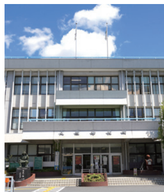
現在、庁舎整備を予定してい る大東市役所本庁
