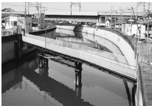
老朽化が激しく架け替え予定の御供田新橋の仮橋
