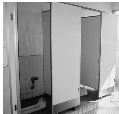
昨年改修されたトイレ
