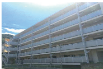
改修予定の嵯峨園第2住宅
