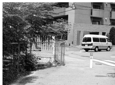
整備が求められる中灰塚地区水路付近
