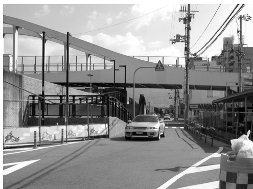
整備が予定されている住之井橋左岸
