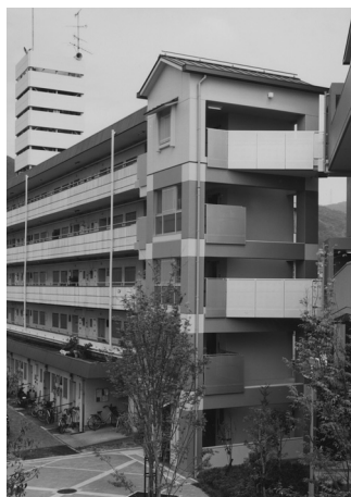
廊下型住棟に設置されたエレベーター棟
