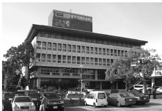
改修工事に伴い耐震診断が行われる市民会館
