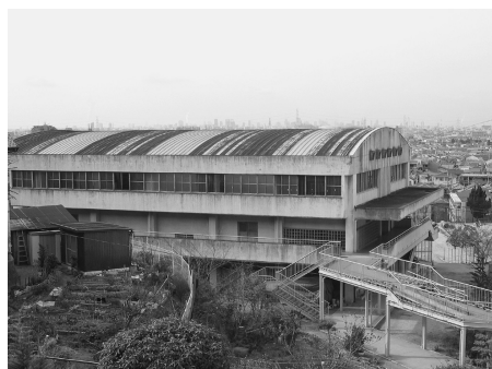
17年度中に改修される北条小学校体育館の屋根
