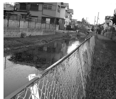
整備が予定されている平野屋会所付近の水路
