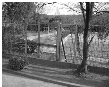
改良される予定の泉公園の非常時用門扉
