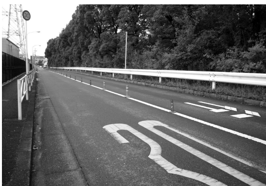
不法駐車対策に設置されているポールコーン
