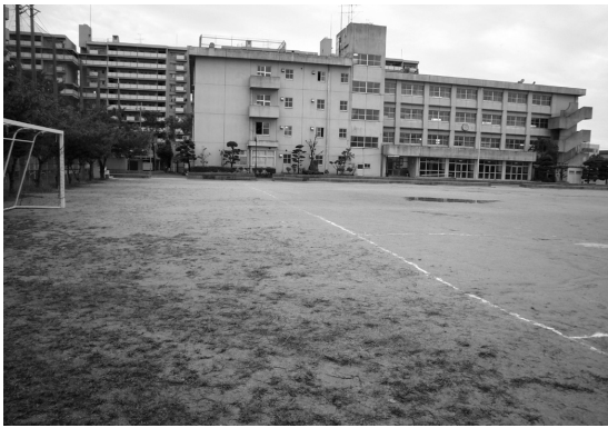
整備の改善策が望まれる学校のグラウンド
