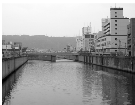
下水道の普及により水質浄化が進む寝屋川
