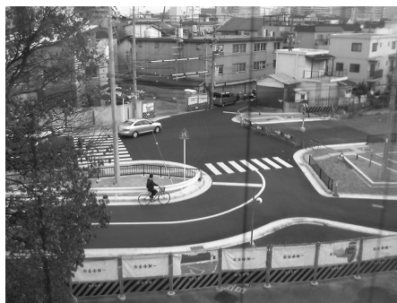
安全対策が望まれる灰塚の水道局前の暫定交差点
