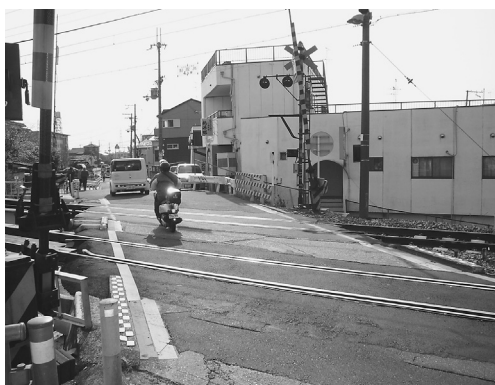
踏切の拡幅・段差の解消など改善が求められる北条踏切
