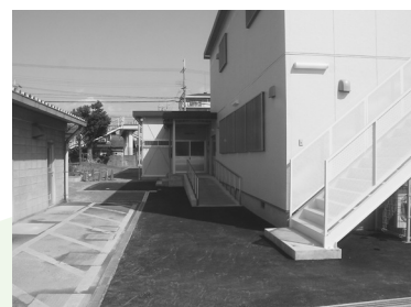
平成20年度に南郷小学校に新築された備蓄倉庫（1階は、放課後児童クラブ）
