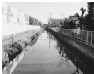
憩いの場として整備される南新田の水路
