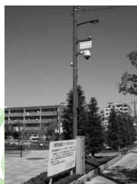
末広公園南側に設置されている警察緊急通報装置（スーパー防犯灯）
