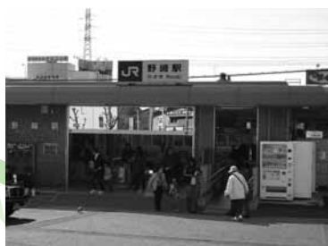
駅舎の橋上化や駅前広場の整備が検討されているJR野崎駅
