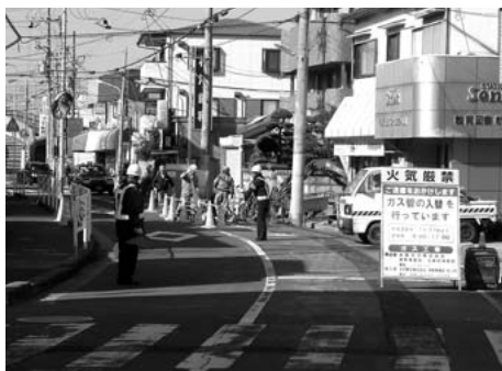
(2)ガス管の入れ替え工事が行われている 泉小学校前の道路
