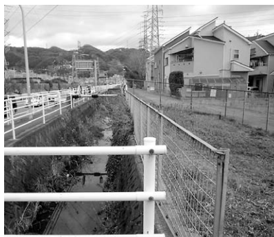
早期の歩道整備が望まれる阪奈道路下り線南側(中垣内6丁目)
