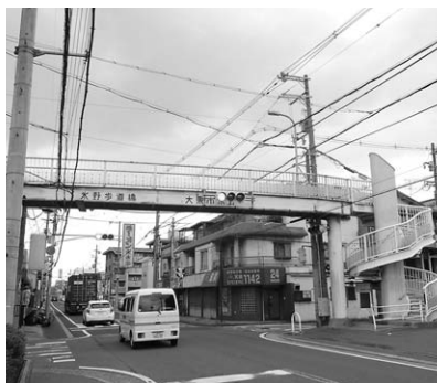
氷野小学校の通学路に指定されている氷野歩道橋 (氷野1丁目・3丁目、大東町付近)
