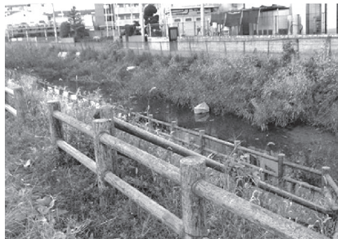
雑草が生い茂る銭屋川沿い (平野屋2丁目・泉町2丁目付近)
