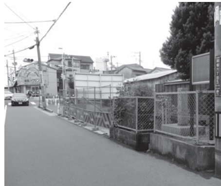
老朽店舗撤去箇所です歩道整備が進められる予定の府道鴻池新田停車場線(諸福6丁目付近)
