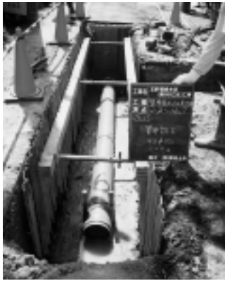
急ピッチで進む下水道工事
