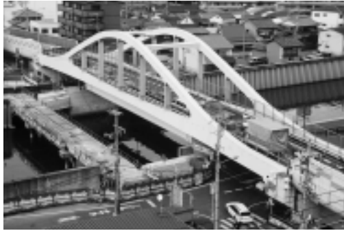
住の井橋西側で進む歩道工事
