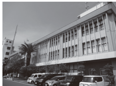
老朽化、狭隘化などの課題解決のため、早期の移転または建て替えが望まれる市役所庁舎(谷川1丁目)
