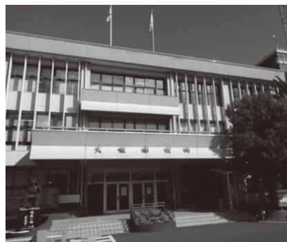
建てかえに向けて新庁舎のあり方など が議論されている市役所本庁舎
