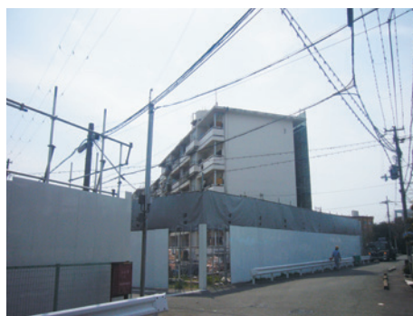
北条まちづくり推進事業を進めるため、解体工事が進行中の市営飯盛園第二住宅（北条3丁目）
