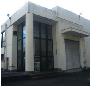
老朽化が進んでおり、存続を精査しながら改修や更新を検討しているポンプ施設(深野北5丁目)
